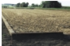
Randbefestigung mit Kunststoffschwelen
