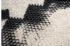
5 Verfüllung der Waben mit Rundkornriesel, Feinsplitt oder Lava (rechtes Bild hinten)
