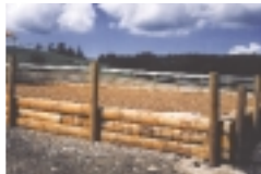
Randbefestigung mit Holzbalken
