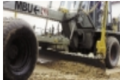
7 Eben der Tretschicht mit Lasergrader
