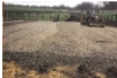
1 Wasserdurchlässiger, standfester Aufbau mit entsprechender Drainage
