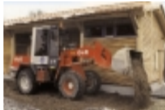
6 Aufbringen der Tretschicht mit Lader über Kopf
